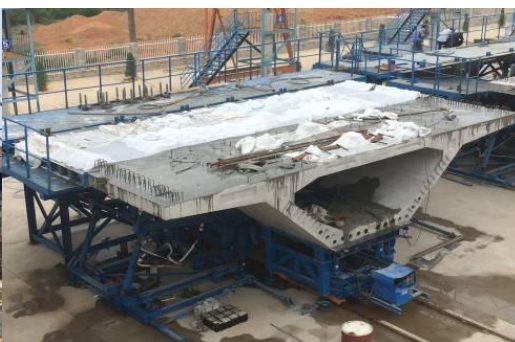
图 3.8-2 短线预制节段箱梁模板
