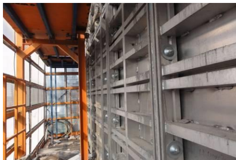
图 3.4-2 爬模模板及架体
