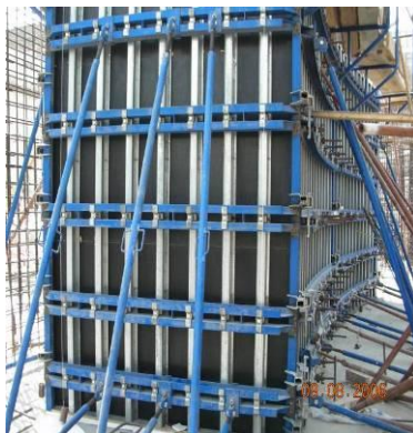
图 3.7-2 清水混凝土模板实例
