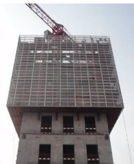
图 3.4-1 液压爬升模板外立面
