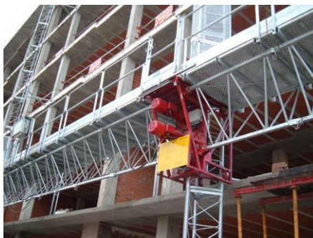
图 3.3 电动桥式脚手架
