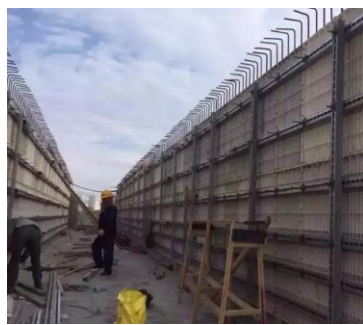
2 混凝土分三次浇筑的模板
