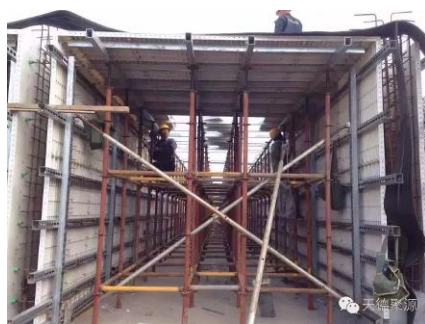
1 混凝土分两次浇筑的模板
