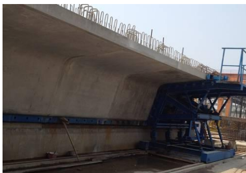
图 3.8-1 长线预制节段箱梁模板
